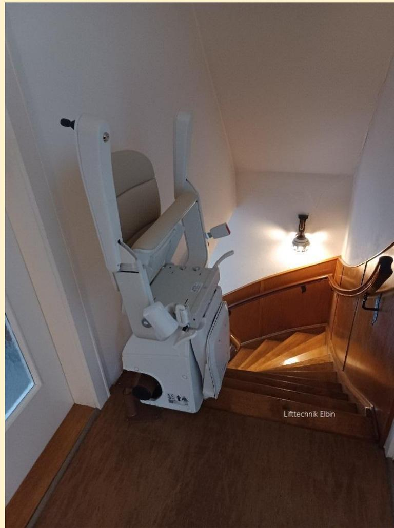
Eine Klappschiene kann eingesetzt werden, wenn sich eine Tür oder ein Durchgang am Fahrbahnbeginn befindet. Diese Klappschiene - Freecurve wird mit der Fernbedienung oder vom Lift aus elektrisch Hoch- bzw. Herunter geklappt.
