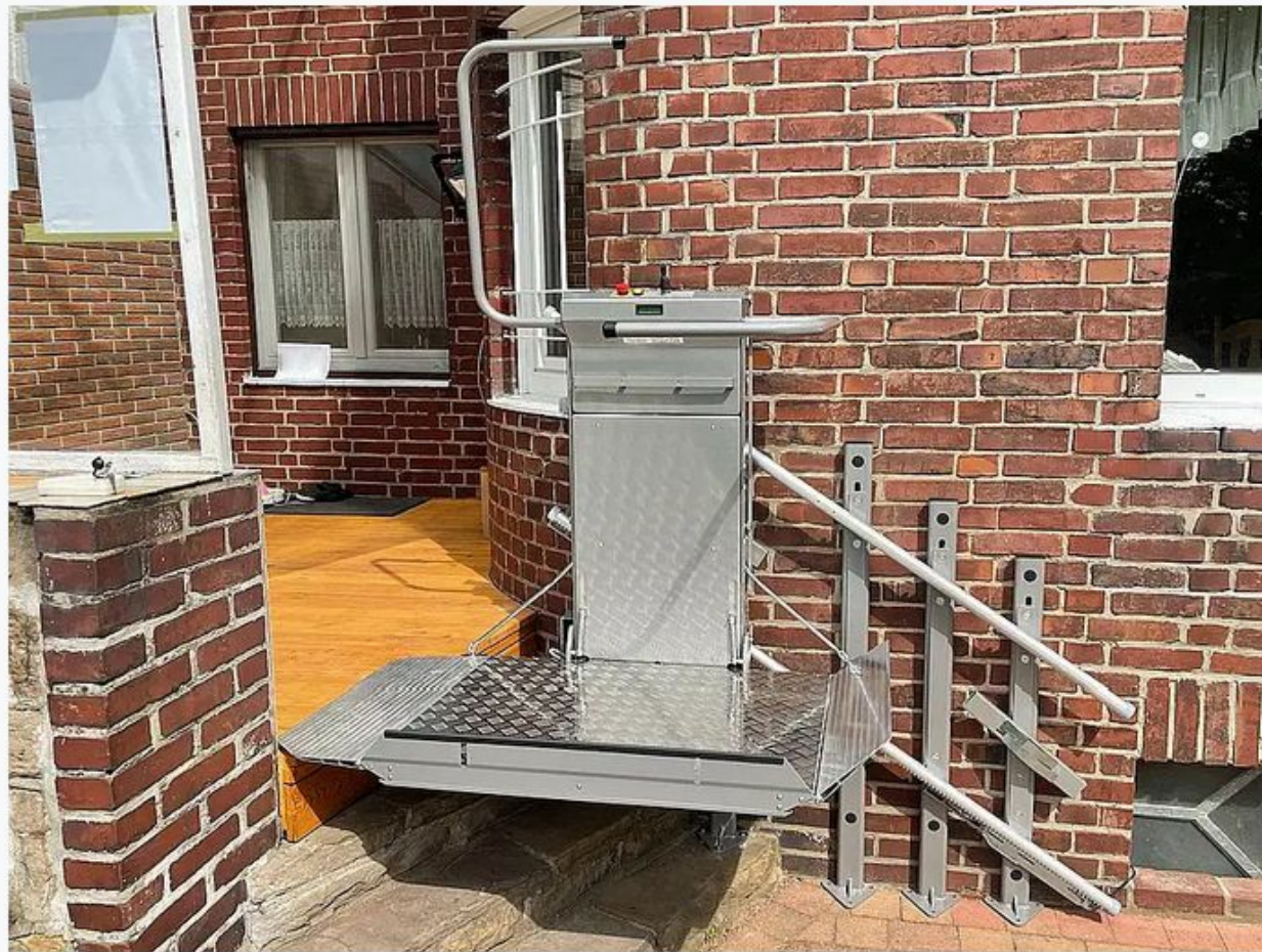
Aussenanlage mit Ständerbefestigung. Liftechnik Elbin
